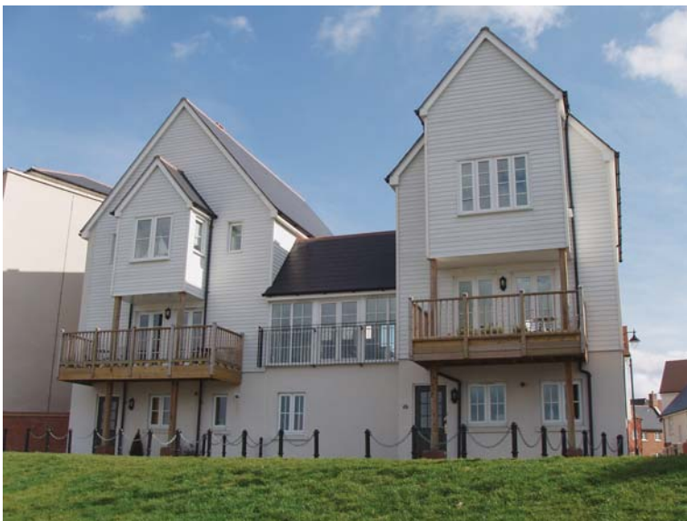
Fig. 9.10 Ingress Park, Kent
