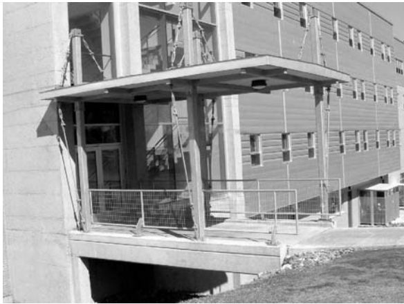
Figure 4. Université de Sherbrooke pedestrian bridge
