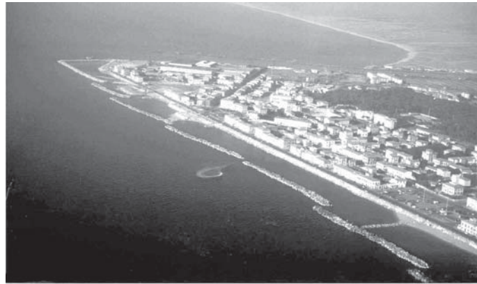
Figure 13: Marina di Pisa: aerial view
